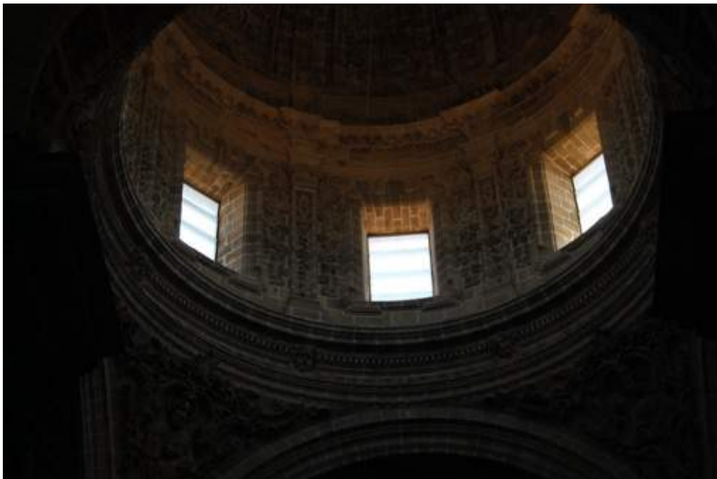
Ilustración 17: Visión de los ventanales del tambor de la cúpula. Compuestos por tres paneles de cristal dispuestos de forma que permitan la renovación de aire sin que el agua de lluvia pueda acceder. [Imagen tomada por José Antonio Romero, 2023]
