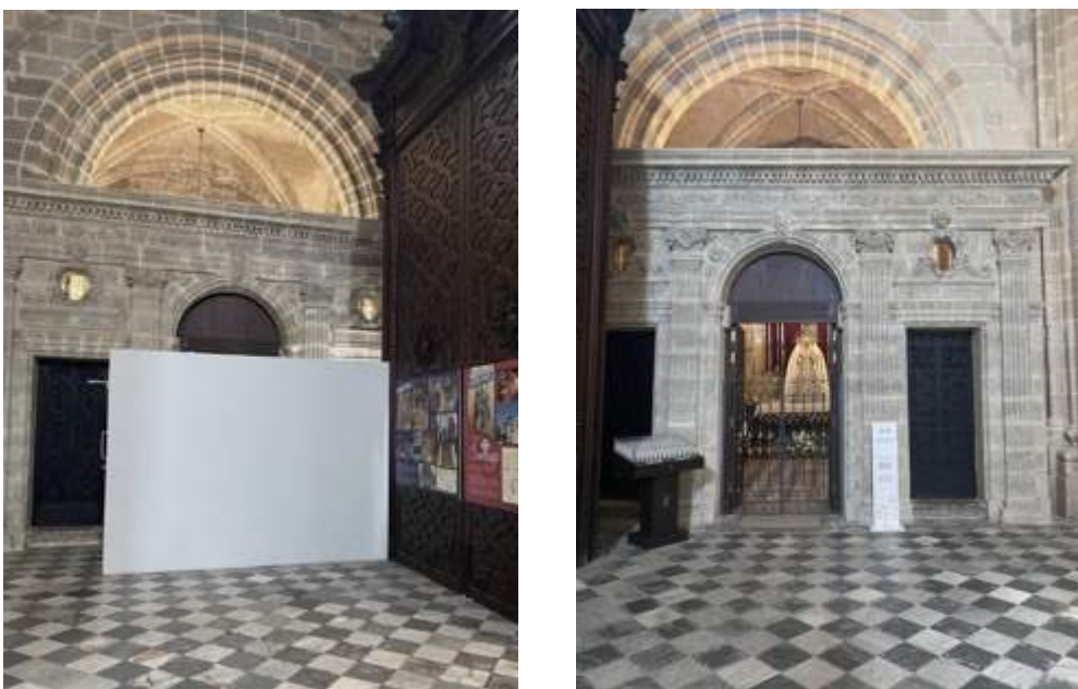
Ilustración 10: Ubicación actual de los paramentos que abrigaban al coro en su primitiva y original ubicación. Hoy día dispuestos cerrando la primitiva capilla bautismal (actual taquilla de venta de entradas y souvenirs) y la capilla de ánimas (actualmente conocida por capilla del resucitado). [Imágenes tomadas por Pablo Tejero Cárdenas, 2023]
