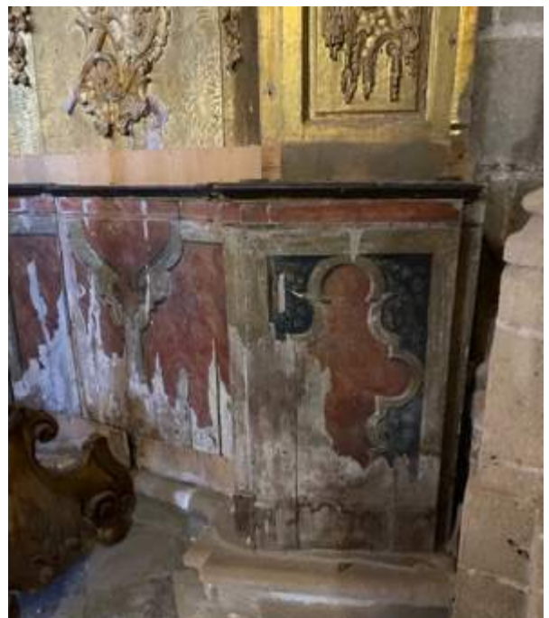
Ilustración 28: Visión del sotobanco del Retablo de San Pedro. En él vemos como la humedad de infiltración proveniente del subsuelo ha afectado gravemente provocando graves pérdidas en la capa de revestimiento o policroma. Además, ha afectado al soporte provocando pudrición de la madera que ha intentado enmascararse con unos añadidos de panel contrachapado. Sin duda un grave problema, que como ya ocurre en otros retablos de la colección, acabará afectando a la estabilidad estructural del retablo. [Imagen tomada por Pablo Tejero Cárdenas, 2023]
