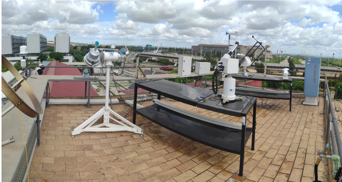
Figura 4.1 Vista de la estación del GTER.
