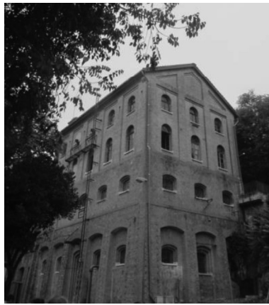
Figura 7: Imagen del estado actual del edificio.
