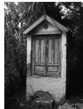
Figura 5: Cuarto de contador de abastecimiento
