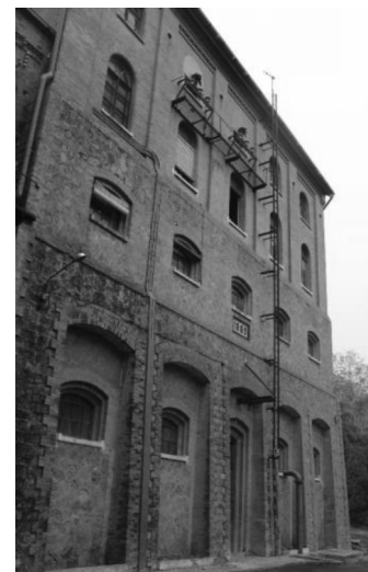
Figura 2: Fachada de ladrillo
