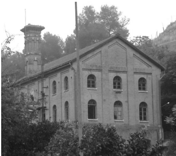
Figura 1: Vista general de la casa de bombeo
