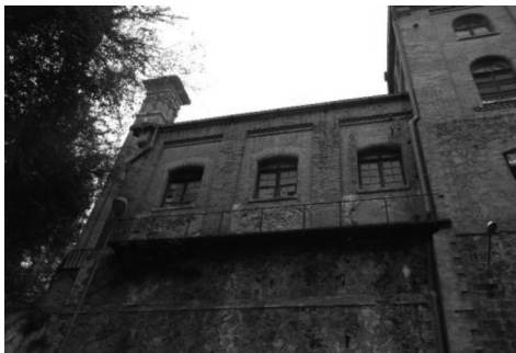
Figura 3: Vista de la fachada de acceso a la carbonería.
