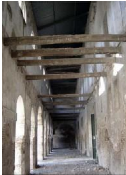
Fig. 36. Fotografía Galería Sur. Amores Carredano, 2019.
