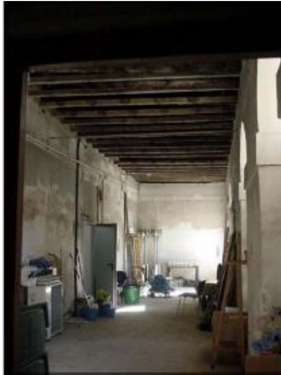
Fig. 34. Fotografía Galería Norte. Amores Carredano, 2019.
