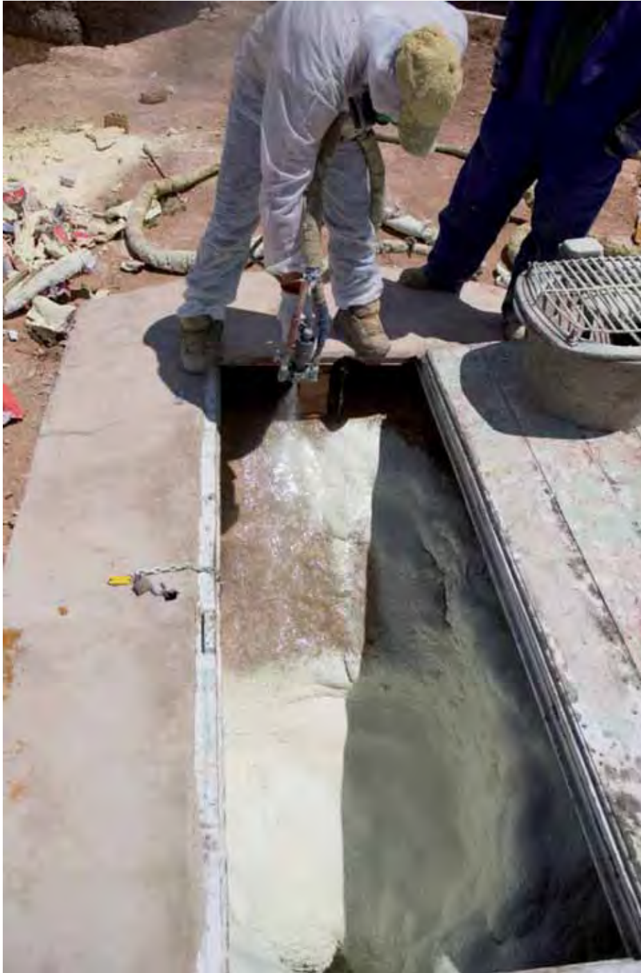
Lámina 10.27. Impregnación de las últimas superficies.
