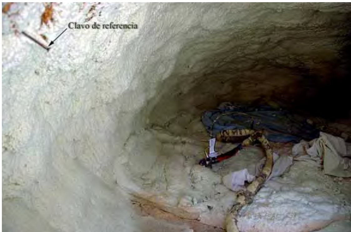
Lámina 10.20. Aspecto del moldeo con la espuma de poliuretano. En el margen superior izquierdo destacamos el registro.
