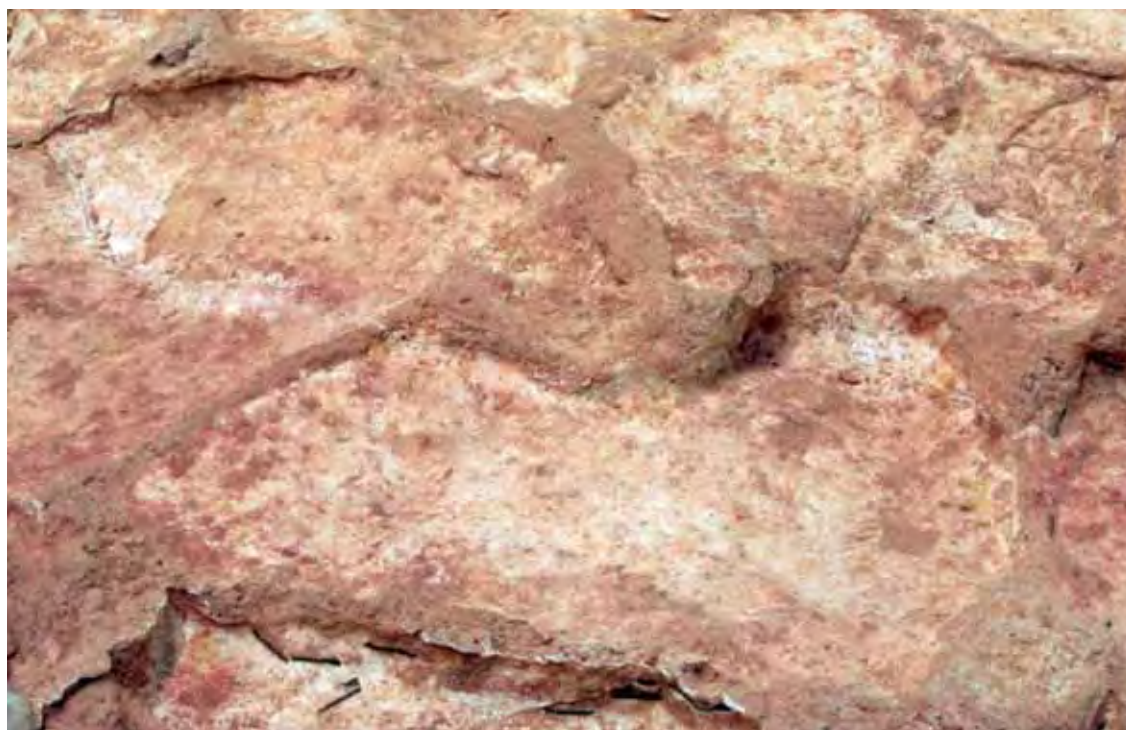
Lámina 10.62. Imagen de la zona que se presenta en la ilustración anterior después de la consolidación del corte.
