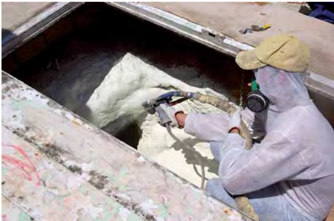
Lámina 10.26. Superposición de estratos de espuma.
