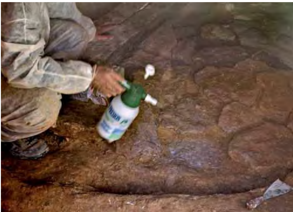
Lámina 10.7. Aplicación de primal para consolidar la superficie de contacto con la silicona.
