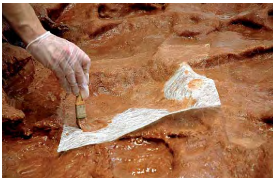
Lámina 10.67. Saturación de la fibra de vidrio con resina en la tercera capa.
