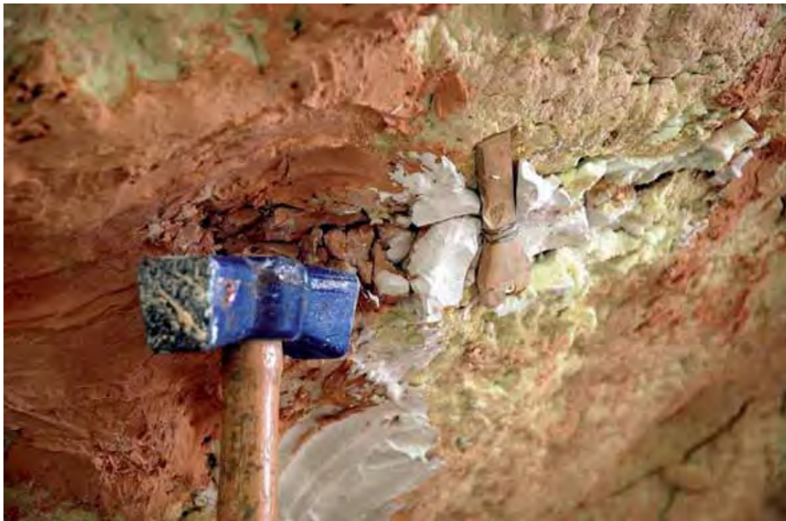
Lámina 10.83. Detalle de la ruptura de las pegaduras realizadas sobre las uniones de la madreforma con yeso reforzado.
