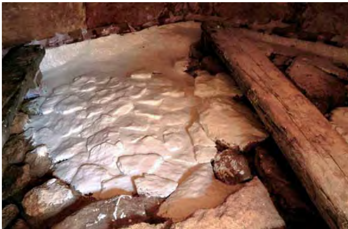
Lámina 10.10. Imagen donde aparecen los dos costeros sobreelevados utilizados como soporte para la aplicación de la silicona.
