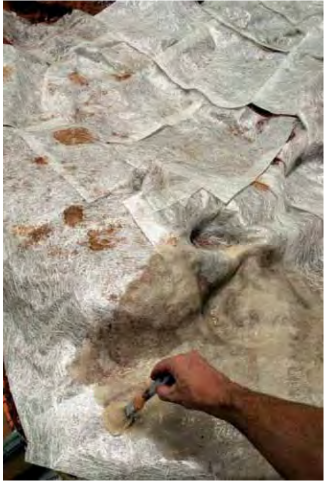
Lámina 10.69. Solapado de la fibra.
