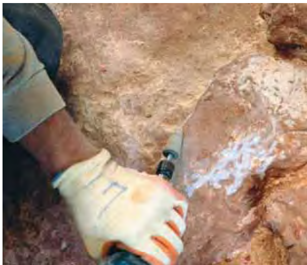
Lámina 10.90. Tratamiento de la resina. Corrección.
