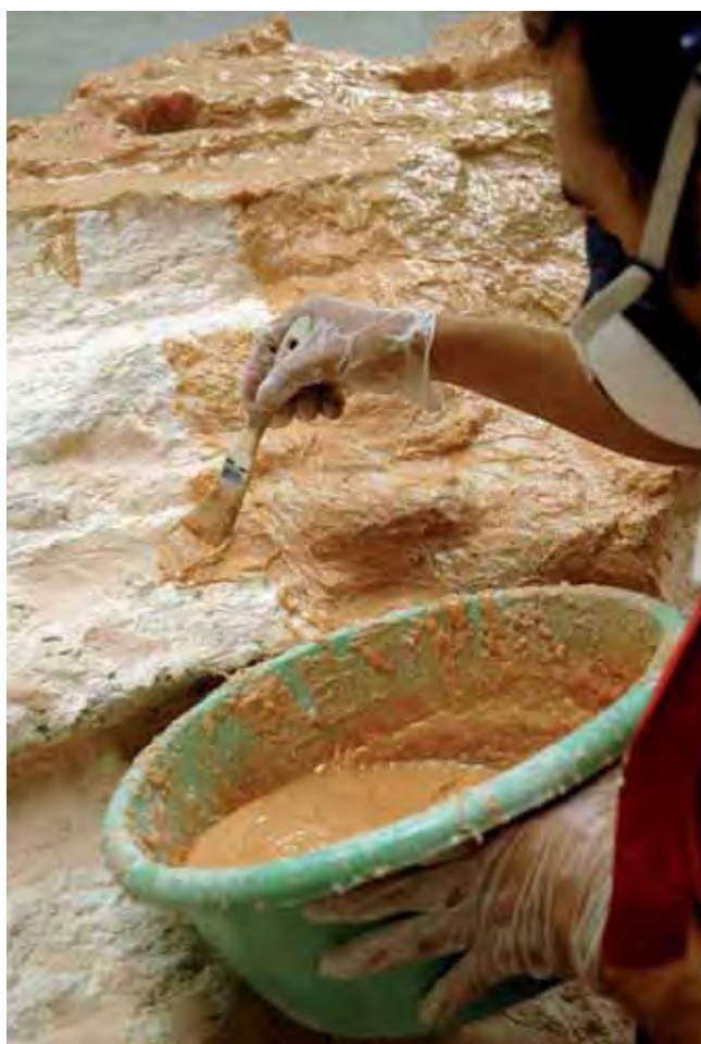
Lámina 10.73. Aplicación del primer estrato de resina sobre la bóveda.
