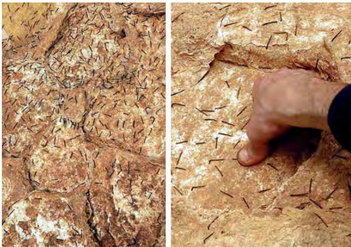
Lámina 10.59. Vista general y detalle de la introducción de las presillas de alambre de ferralla en la silicona
