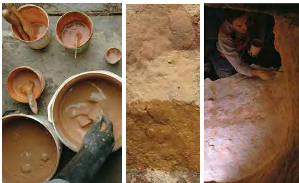
Lámina 10.91. Preparación de los colores, y la evolución de la gama en tres tonos durante el proceso de secado de las jabelgas de cal.
