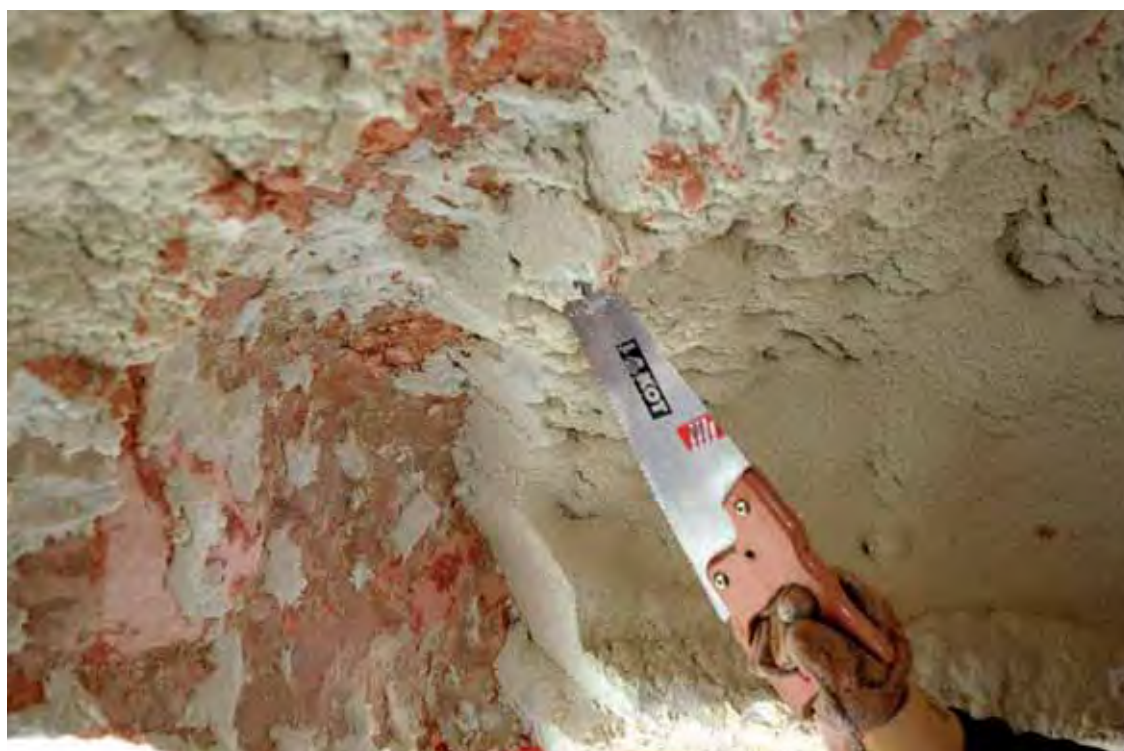
Lámina 10.78. Desbastado con serrucho.
