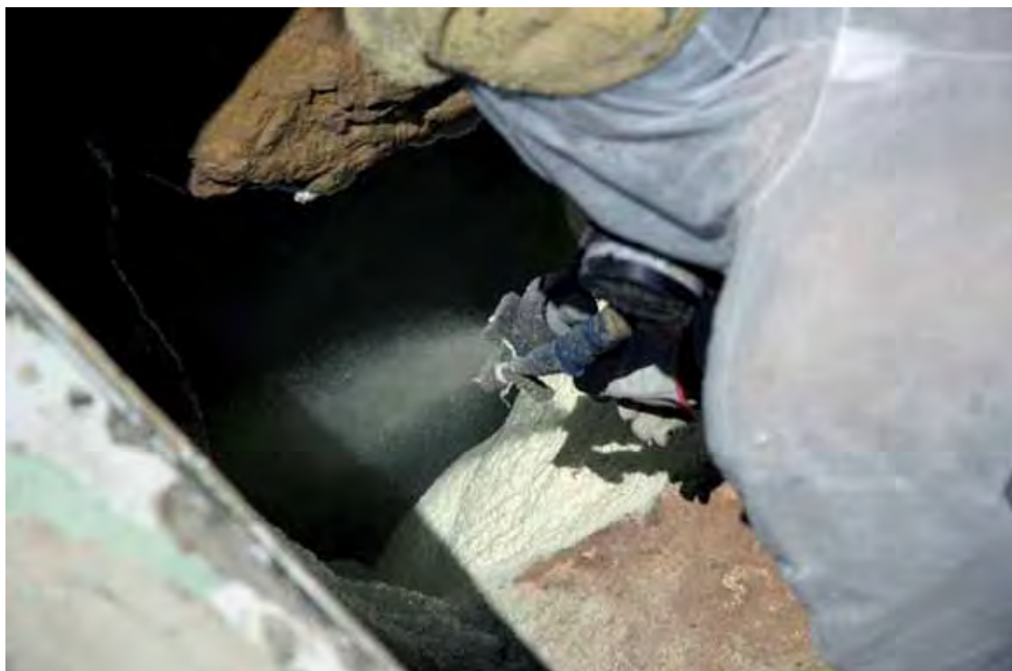
Lámina 10.24. Proyección del poliuretano en el acceso de la Cueva.
