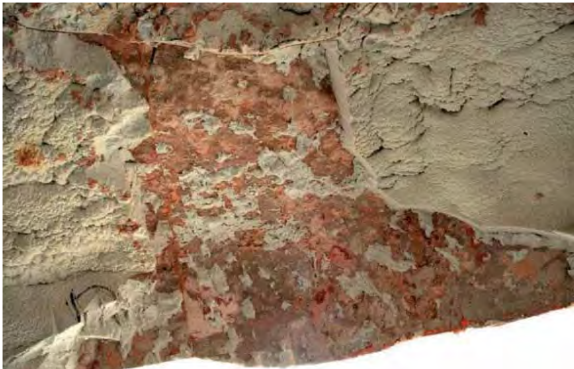
Lámina 10.80. Aspecto de la pared interior una vez retirado el poliuretano.
