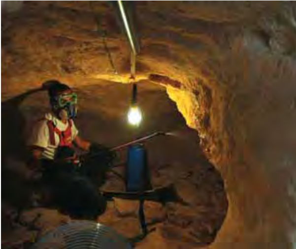
Lámina 10.97. Consolidación del interior con Primal.
