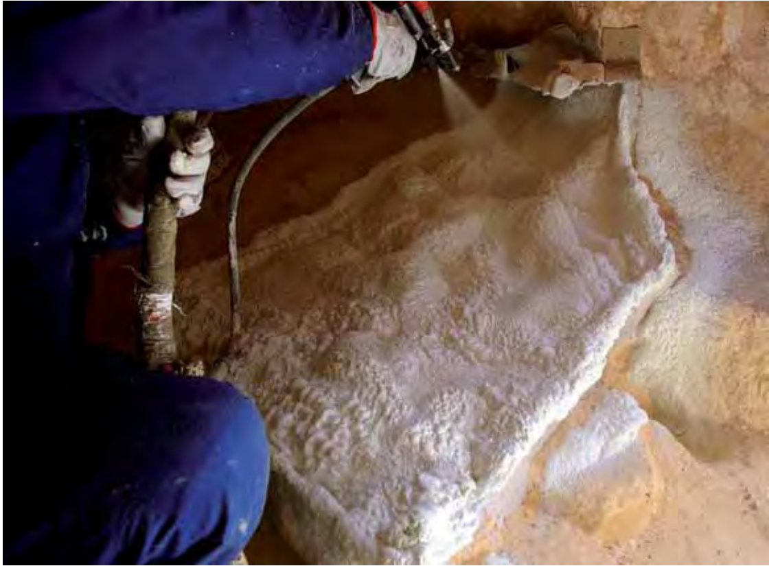
Lámina 10.14. Capas sucesivas.
