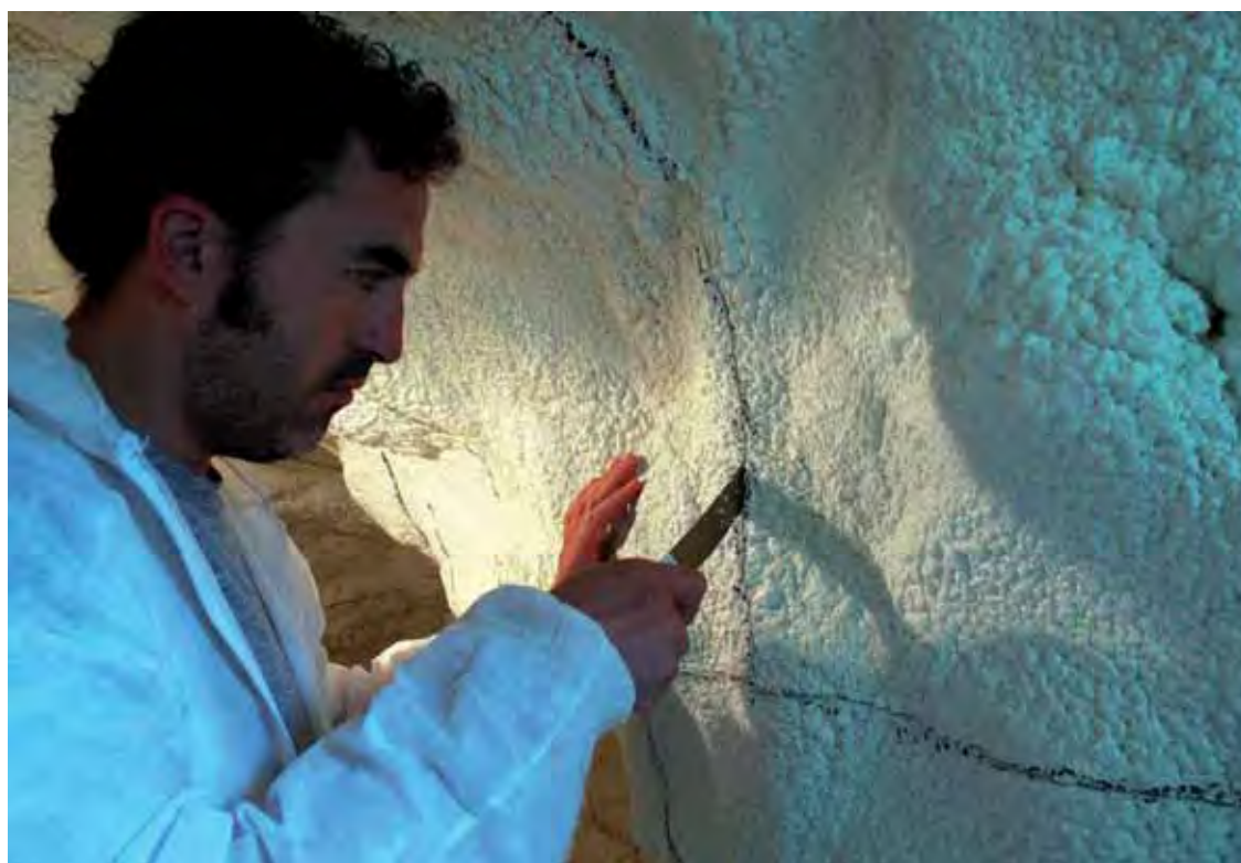
Lámina 10.30. Corte de las divisiones trazadas en la bóveda.
