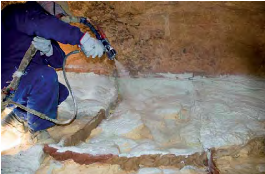
Lámina 10.16. Proyección del poliuretano y expansión del mismo sobre diferentes piezas aisladas.
