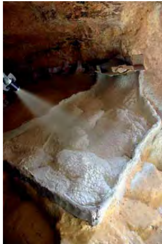
Lámina 10.12. Proyección de la espuma de poliuretano.
