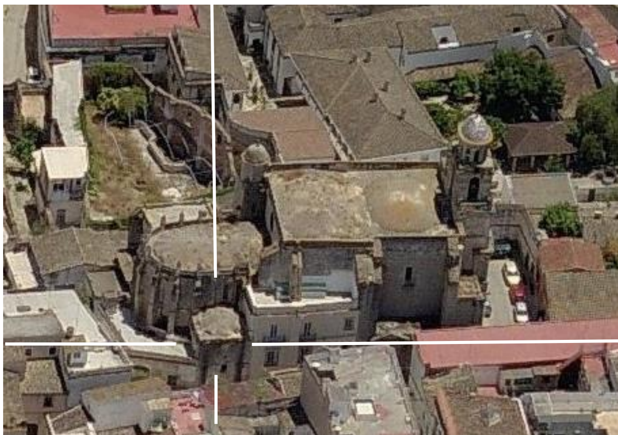
Figura 1: Vista exterior de la iglesia de San Juan de los Caballeros (Jerez de la Frontera, Cádiz)
