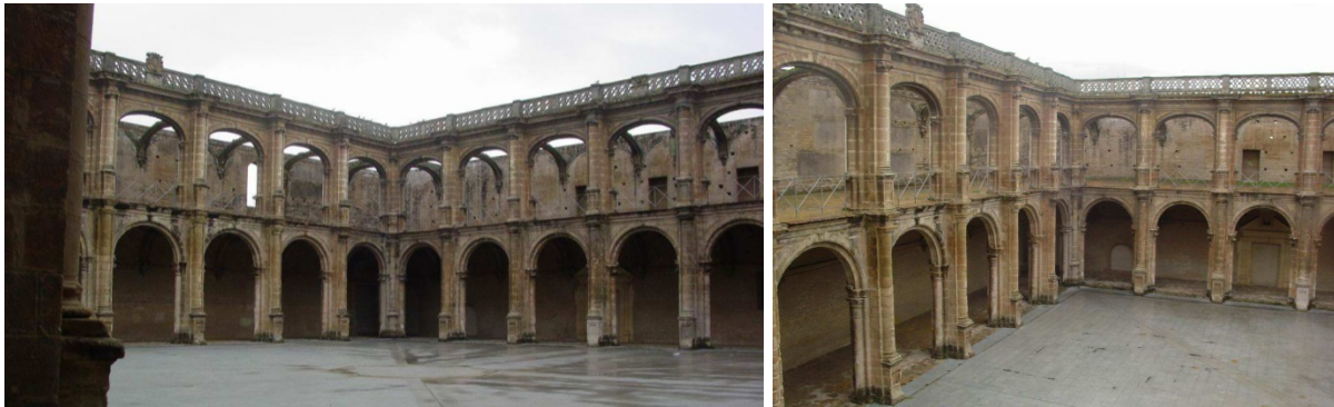
Figuras 3 y 4: Vistas de las fachadas sureste y suroeste del claustro principal.
