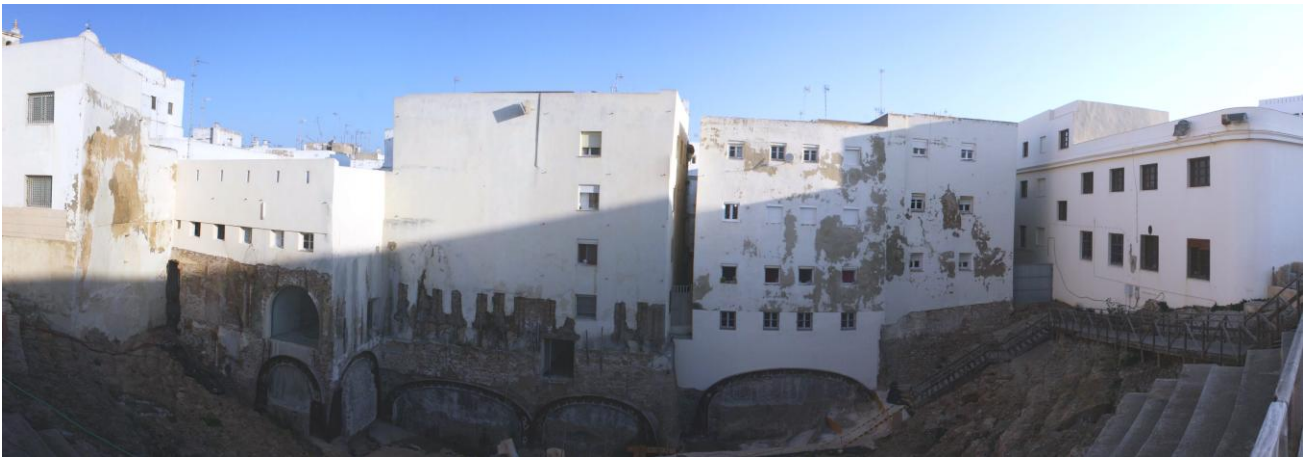
Figura 17. Área del Teatro Romano de Cádiz. Bóvedas de hormigón ya conformadas (marzo, 2012)
