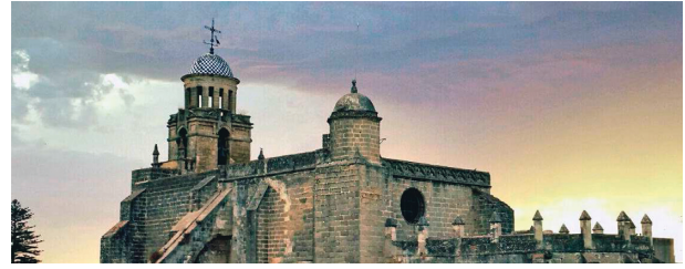
FIGURE 1: San Juan de los Caballeros church, Jerez de la Frontera.
