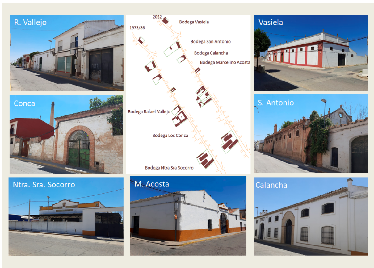
Figura 6. Evolución gráfica de las bodegas para la aplicación de Estrategia de Reutilización de las Instalaciones Vitivinícolas en el Carril de los Moriscos como referente de Ruta Cultural Turística. Imágenes del estado de los edificios.
