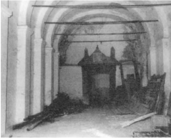
Vista parcial del estado anterior a la obra
