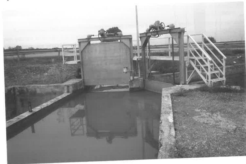
Figure 9.3. Système de fermeture de portes automatisée à la CI du secteur B-XII.
