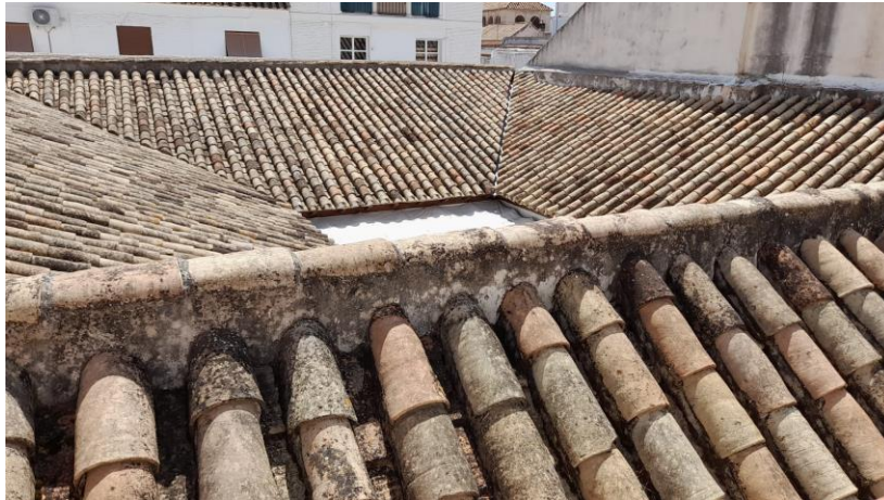
Ilustración 14: Vista de la cubierta desde la azotea de la tercera planta
