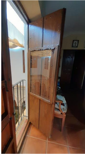
Ilustración 9: Hoja de la ventana y su contraventana cerrada
