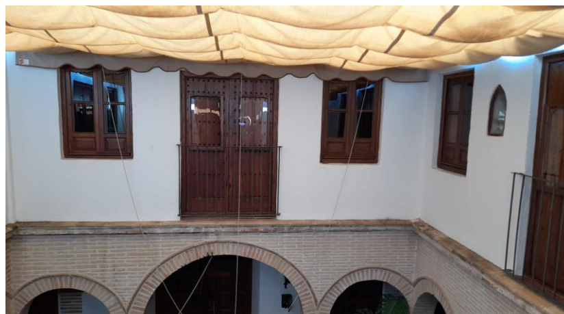
Ilustración 11: Vista del toldo desplegado desde la planta alta
