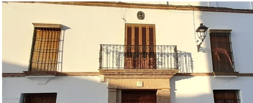
Ilustración 10: Detalle protección solar balcón y ventanas fachada planta superior.
