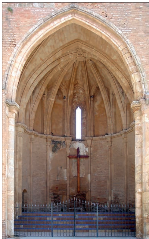
Fig. 3 – Cabecera de la iglesia de San Martín. Fotografía del autor.
