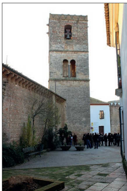
Fig. 4 – Cabecera de la iglesia de San Martín. Fotografía del autor.
