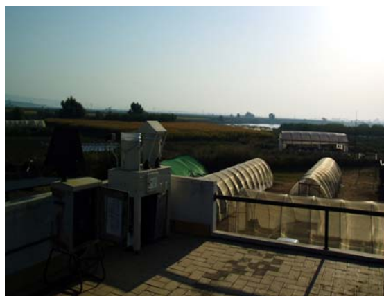
Figura II.5. Azotea del IFAPA Las Torres.
