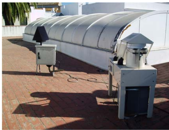
Figura II.24. Azotea del edificio de la Delegación de A.A.S.S. de Chipiona
