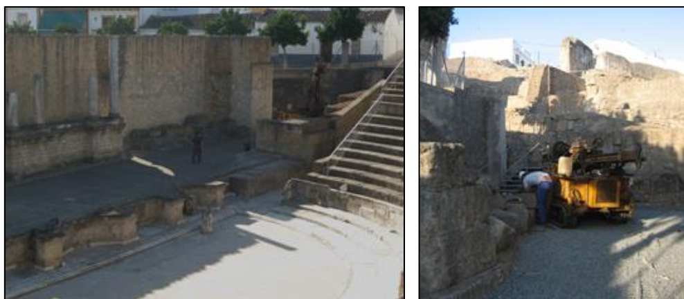
Figura 5.45. Emplazamiento de la sonda durante la realización del sondeo SVU18.
