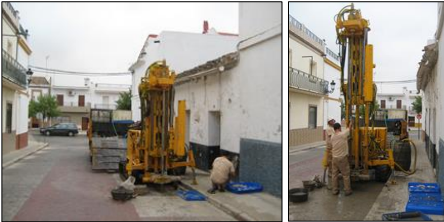
Figura 5.24. Preparativos para la extracción del relleno de la paleovaguada de la calle Real (SVU9).
