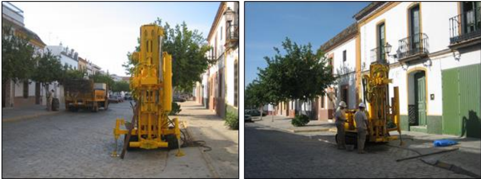
Figura 5.15. Emplazamiento de la maquinaria en la calle Mesones para la ejecución del Sondeo SVU6.
