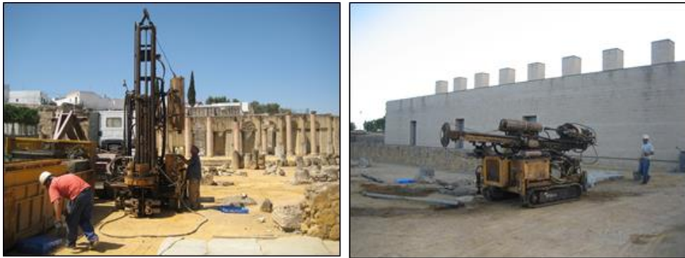
Figura 5.41. Emplazamiento de la sonda para llevar a cabo el sondeo SVU17.
