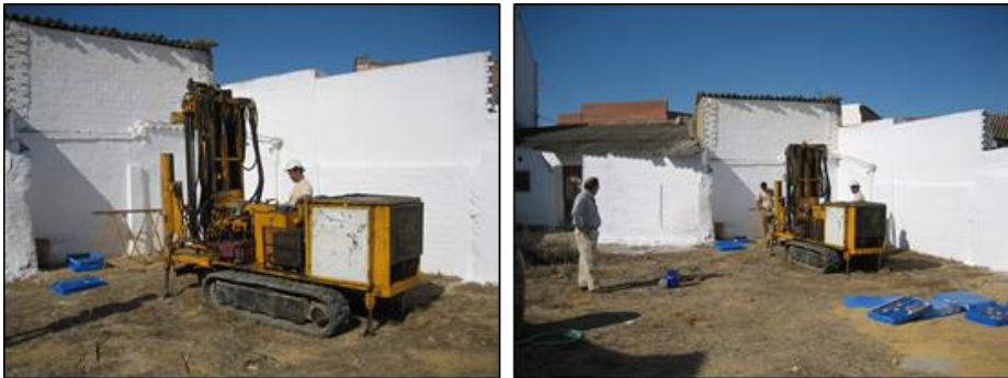
Figura 5.6. Emplazamiento y preparación de la sonda para ejecución del sondeo SVU3.
