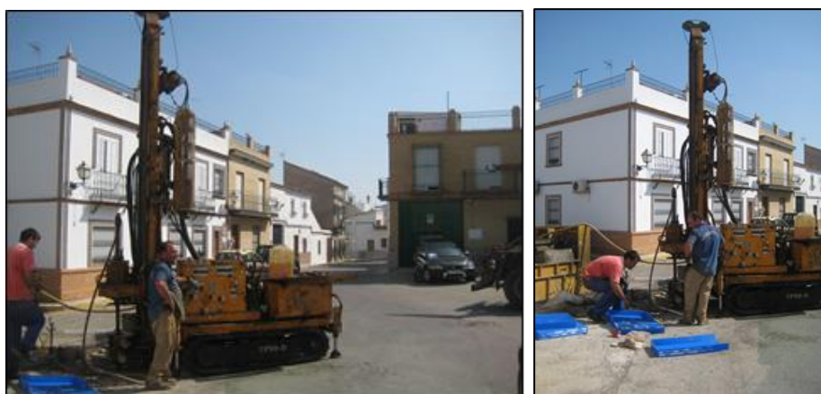
Figura 5.29. Emplazamiento y primeras maniobras del sondeo SVU11.
