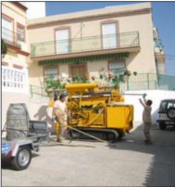
Figura 5.21. Emplazamiento de la sonda para ejecución del sondeo SVU8.
