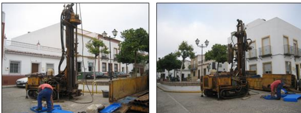
Figura 5.27. Emplazamiento de la sonda para la realización del sondeo SVU10.
