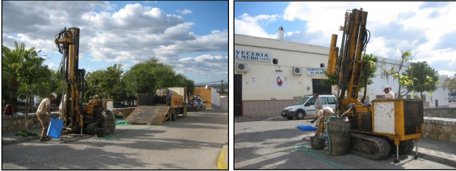
Figura 5.12. Emplazamiento de la sonda para la ejecución del sondeo SVU5.
