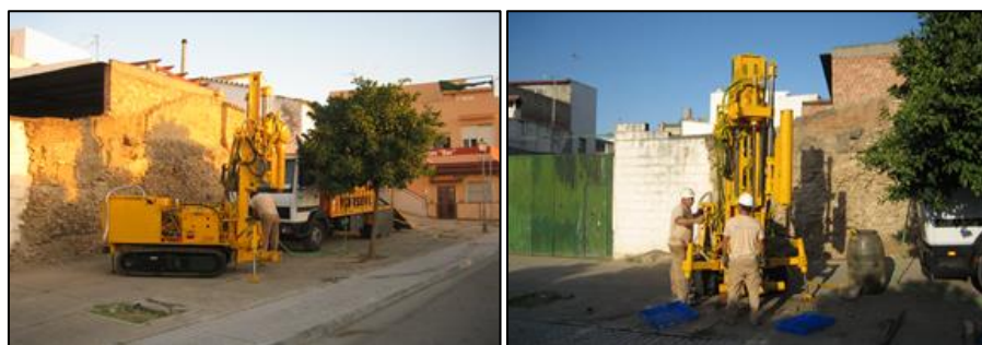
Figura 5.18. Operarios trabajando en la perforación SVU7, junto al muro romano de la N-630.
