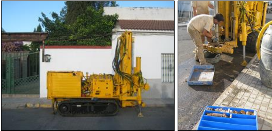
Figura 5.32. Preparación de maquinaria y primeras maniobras.
