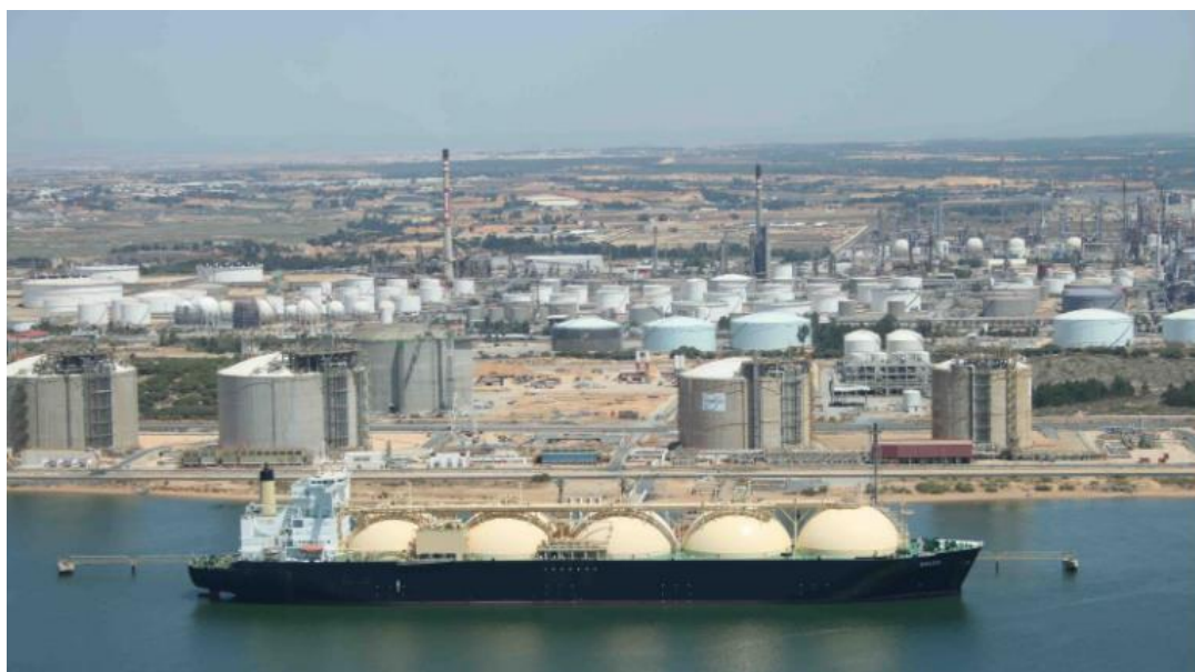
Figura 6_ Planta Regasificadora de Huelva. Fuente: Enagás
