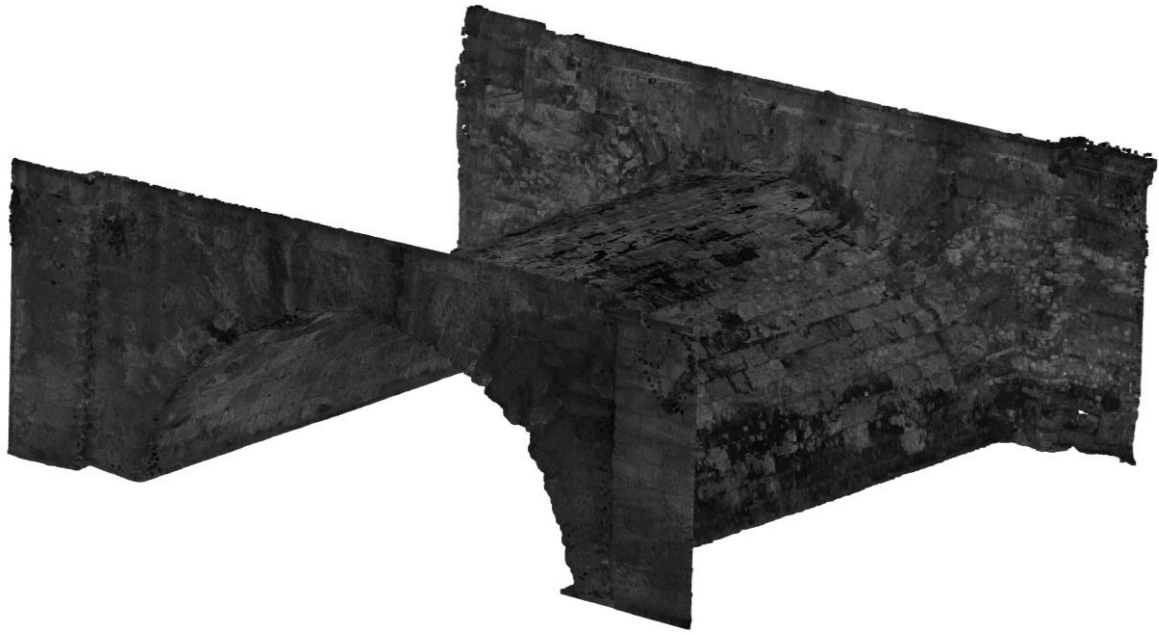
Figura 25: Nube de puntos del arco marineru recortada. Fuente: elaboración propia en CloudCompare
