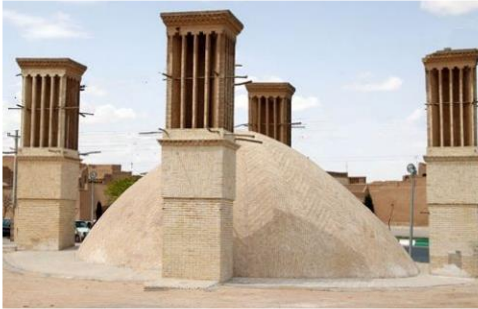
Figura 15. Cisterna con torres de viento, Irán
