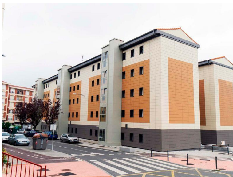
Figura 30. Instalación de ascensor sobre acerado
