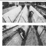
Imágenes de la construcción
