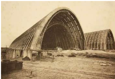
Hangares para dirigibles de Orly (1923) - Eugène Freyssinet
