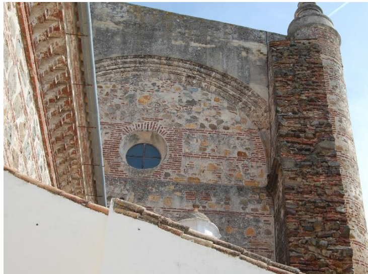
Fig. 4.20. Cierre de la nave lateral (Autor).
