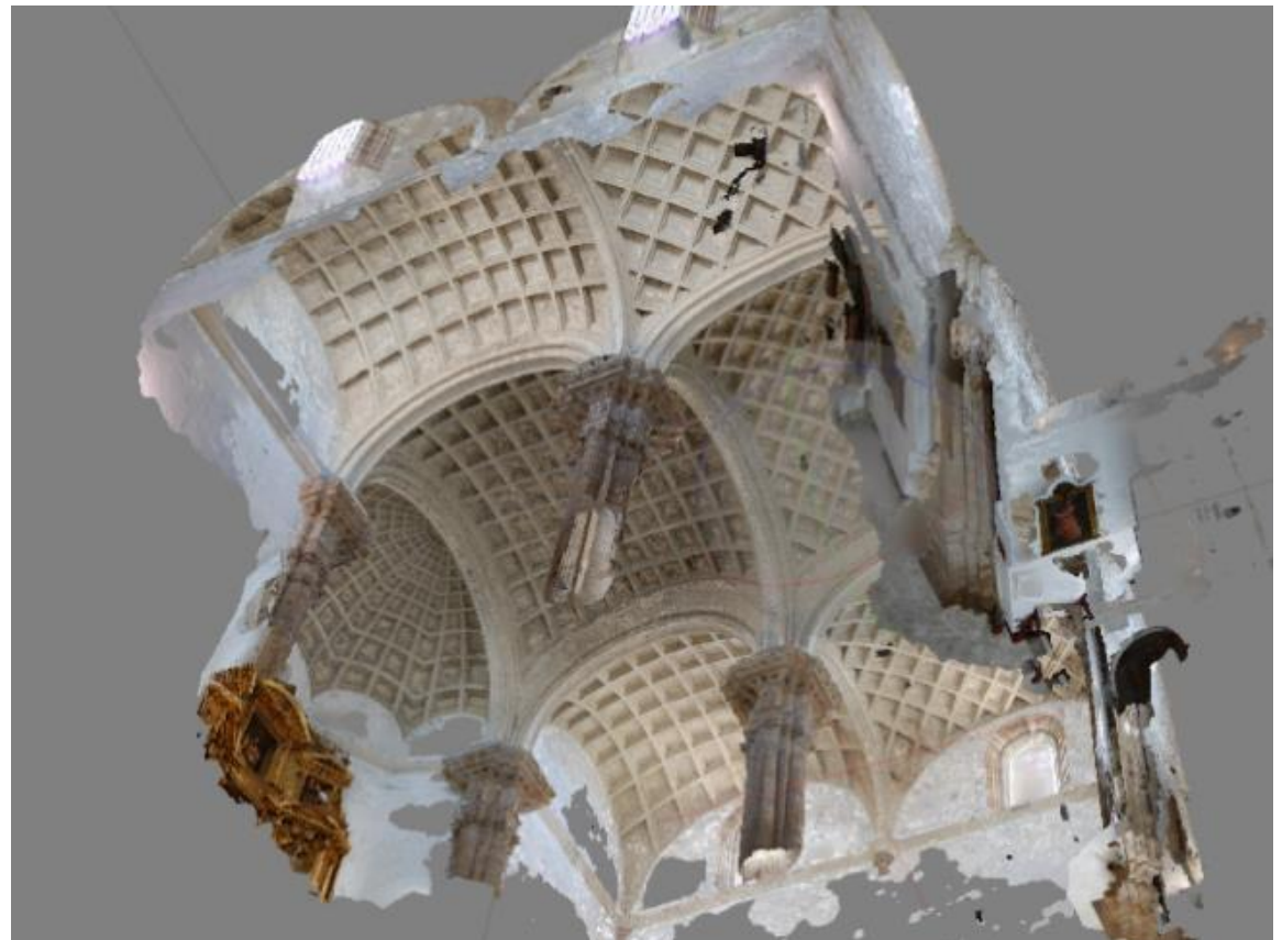
Fig. 1.5. Perspectiva del levantamiento por nube de puntos de las bóvedas (Autor)
