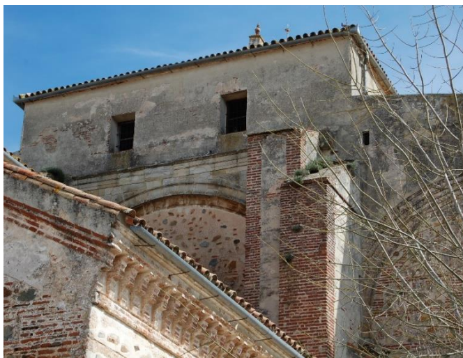
Fig. 2.17. Estribos (el de la izquierda y más alto aguanta las bóvedas mudéjares, y el de la derecha, un poco más bajo, aguanta las bóvedas renacentistas (Autor)
