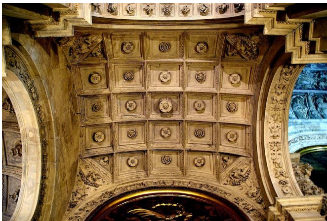
Fig. 2.25. Bóveda de casetones sobre el altar de San Lorenzo, Sacristía Mayor de la catedral de Sevilla ( https://commons.wikimedia.org/ , Pepe Becerra)
