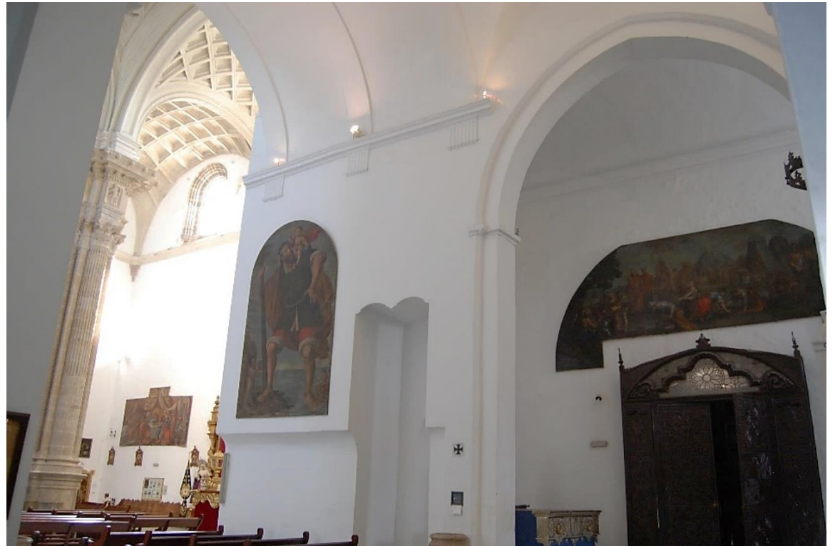
Fig. 2.19. Vista de los estribos que sostienen el empuje de las bóvedas renacentistas y de la estructura mudéjar (autor)
