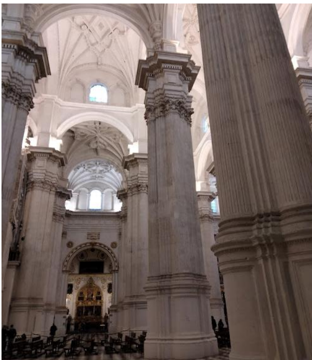
Fig. 2.13. Pilares "siloescos" de la Catedral de Granada (Autor)
