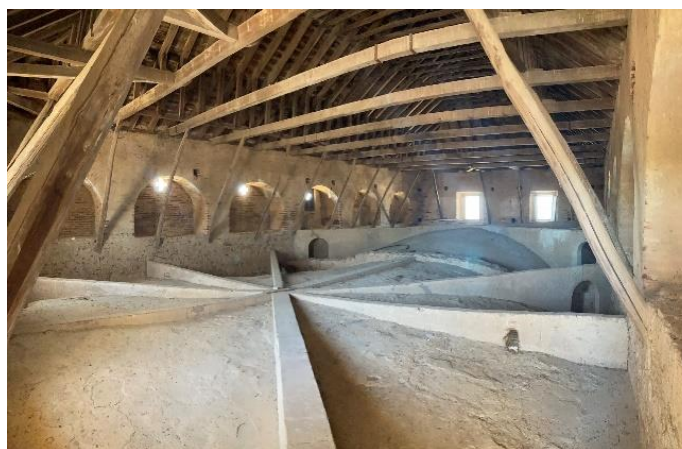
Fig. 3.5. Trasdós de las bóvedas centrales (Autor)
