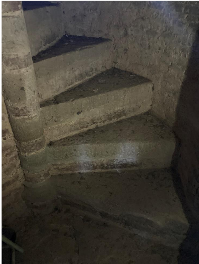
Fig. 4.8. Escalera de "caracol de husillo" de la iglesia de Cazalla de la Sierra (Autor)
