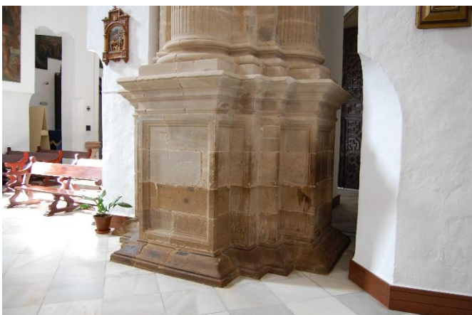
Fig. 2.18. Pasillos resultantes entre los estribos de la obra renacentista y mudéjar (Autor)
