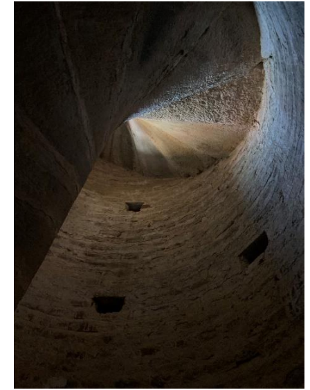
Fig. 4.12. Escalera de "caracol de husillo" de la iglesia de Cazalla de la Sierra (Autor)
