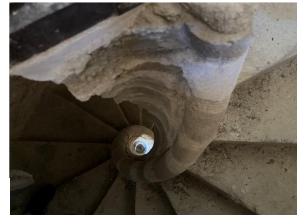
Fig. 4.9. Escalera de "caracol de mallorca" de la iglesia de Cazalla de la Sierra (Autor)
