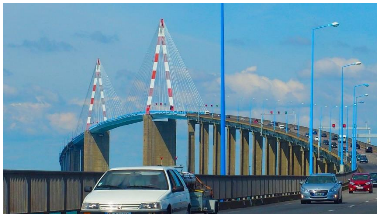
Figura 31. Puente de Saint-Nazaire. (Fuente: [9])
