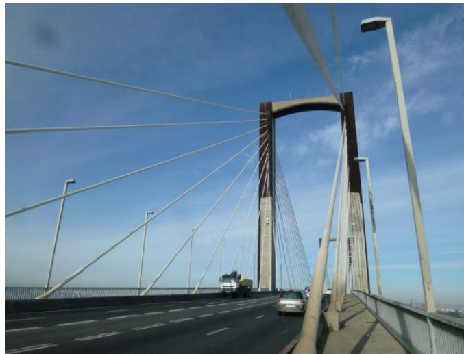
Figura 39. Vista de Pila y Atirantamiento desde la plataforma. (Fuente:[15])
