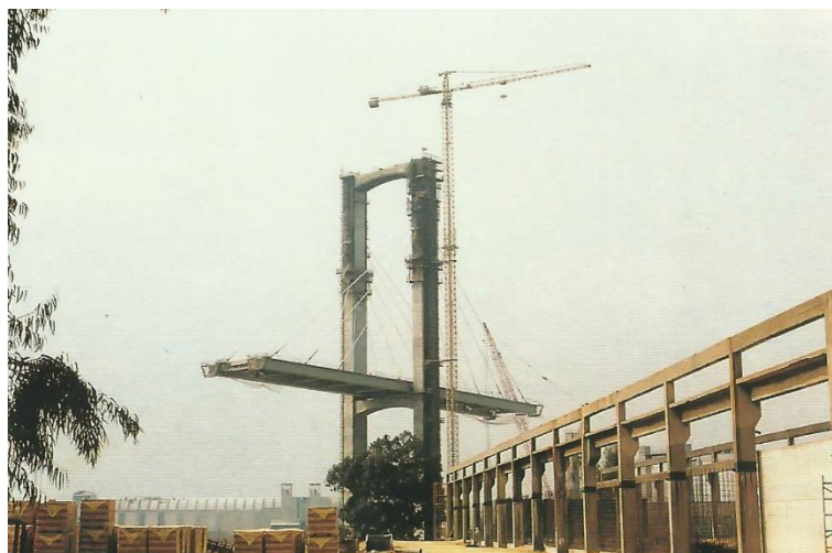
Figura 94. Construcción del Puente del Centenario. (Fuente:[21])
