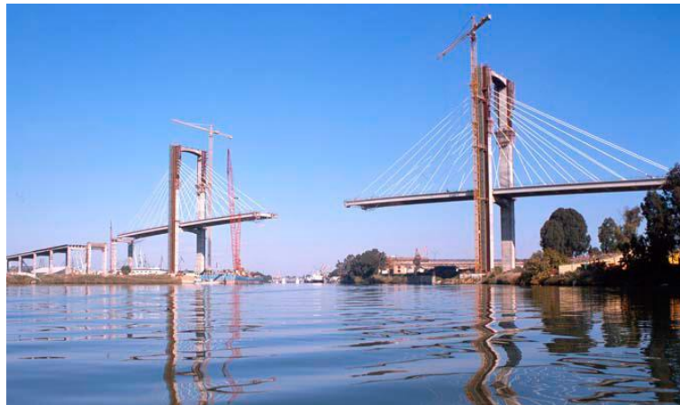
Figura 97. Montaje del tablero. (Fuente:[21]).
