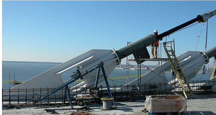
Figura 12. Anclaje pasivo. (Fuente: [2])
