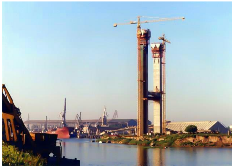
Figura 92. Construcción de los arcos del puente. (Fuente: [21])
