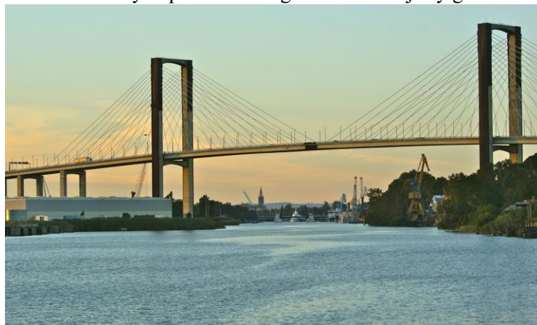
Figura 9. Ejemplo de disposición de tirantes intermedia. (Fuente:[2])
