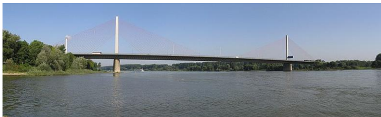
Figura 29. Puente Friedrich Ebert. (Fuente:[2])
