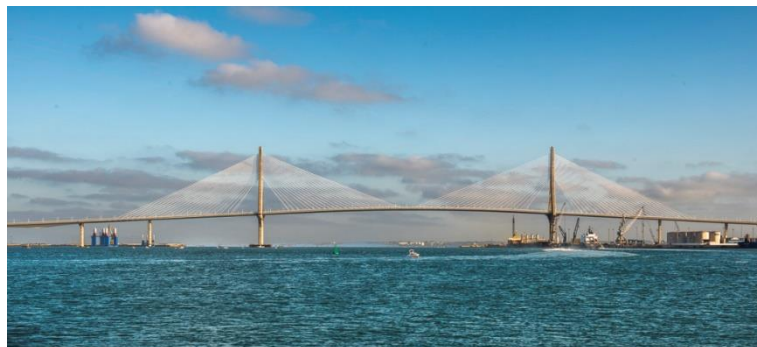
Figura 35. Puente de la Constitución de 1812. (Fuente:[11])
