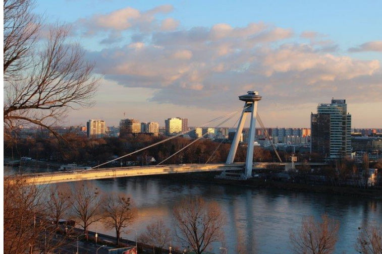
Figura 30. Puente Most SNP. (Fuente:[8])
