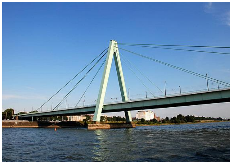
Figura 26. Puente Severin de Colonia. (Fuente:[2])
