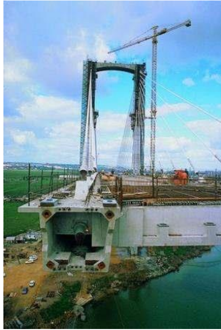
Figura 96. Hormigonado de dovelas. (Fuente:[21])
