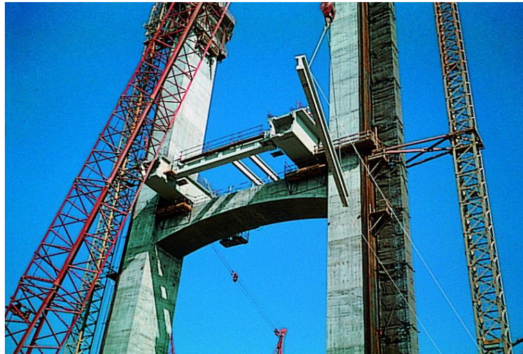
Figura 93. Construcción de la primera dovela. (Fuente: [22])
