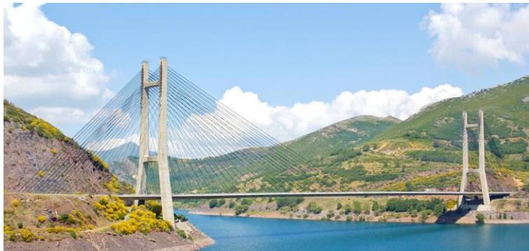
Figura 33. Puente de Barrios de Luna. (Fuente:[2])
