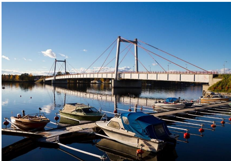
Figura 24. Puente de Strömsund. (Fuente:[2])
