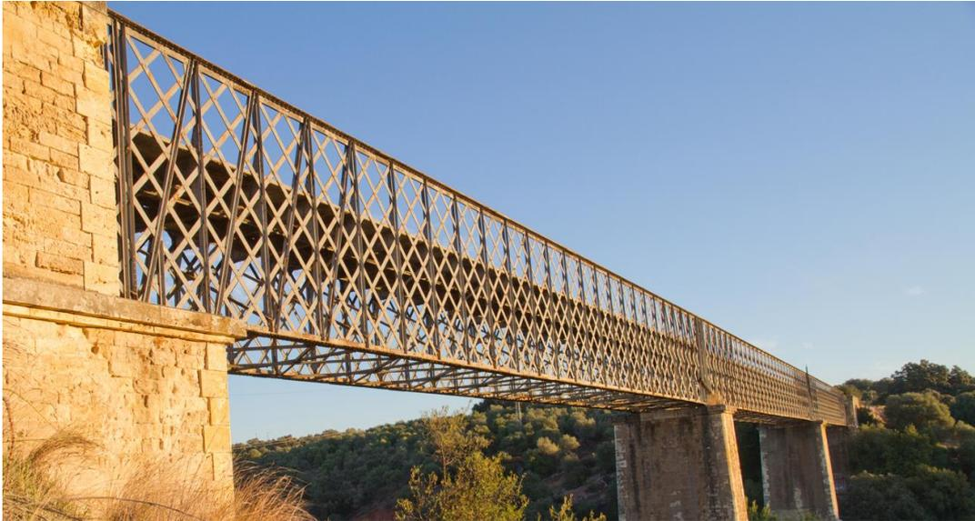
Figura 3.10: Vista de la celosía lateral del Puente de los Pedroches.
