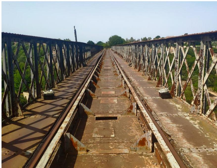
Figura 2.5: Dos acelerómetros triaxiales usados durante los ensayos dinámicos sobre el puente.
