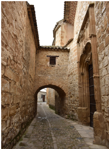
Figura 12. Catedral de Baeza. Pasadizo elevado de la capilla de san Juan de Ávila.
