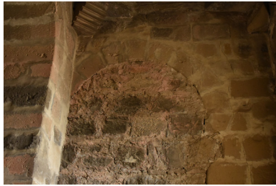
Figura 7. Torre de la Catedral de Baeza. Interior. Detalle de arco de herradura cegado.
