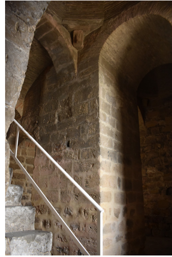
Figura 9. Torre de la Catedral de Baeza. Interior. Soporte central de cantería.
