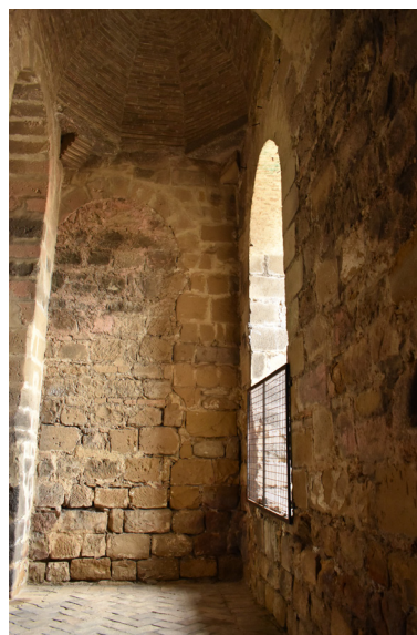
Figura 6. Torre de la Catedral de Baeza. Interior. Arco de herradura cegado y apoyo de viga.
