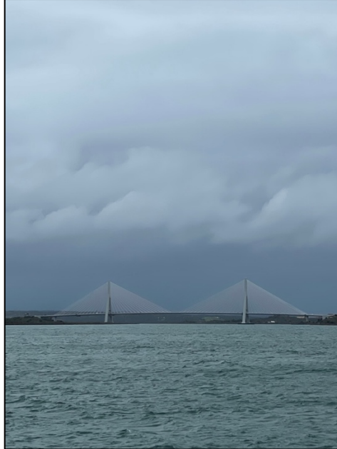
Fotografía 1: Perspectiva del Puente Internacional desde Ayamonte
