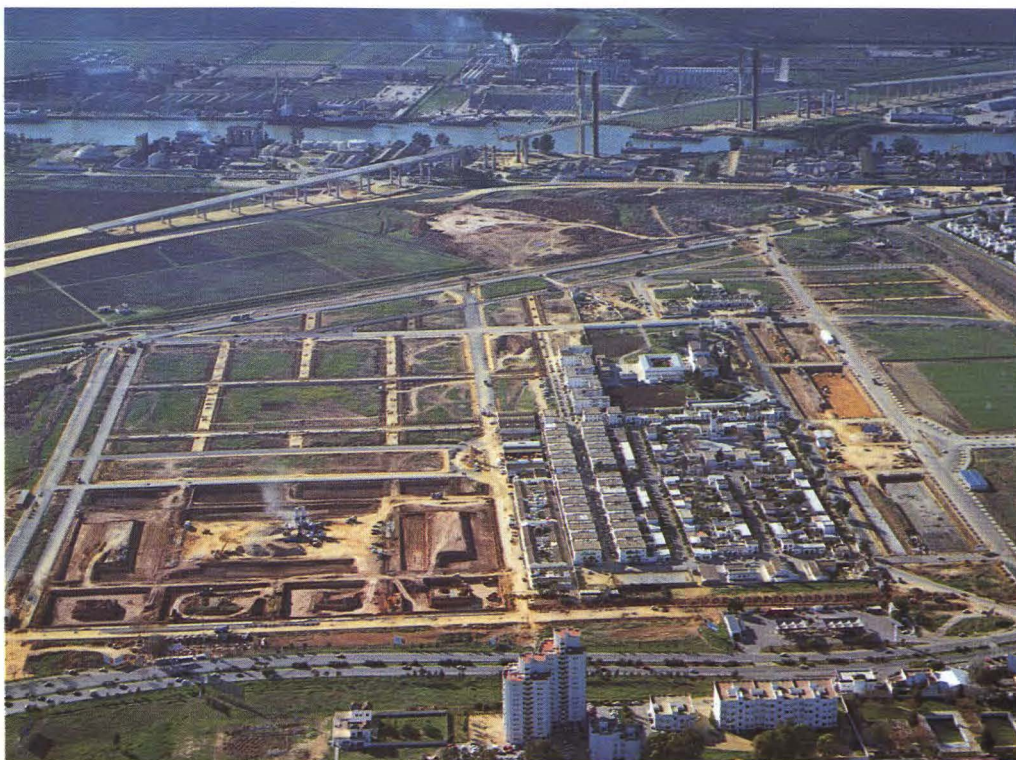
Situación de ejecución del Sector Norte. Junio 1991.
