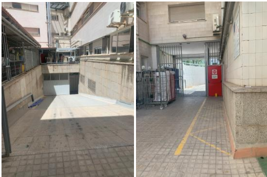
Imagen 1. Salida rampa mantenimiento.
