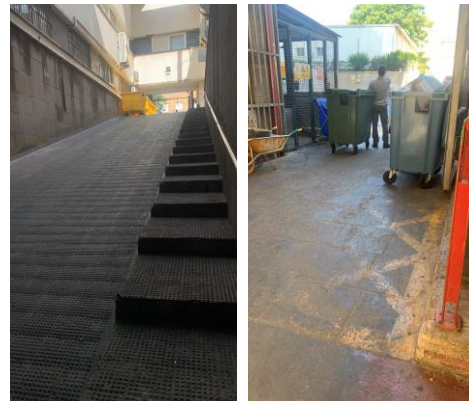
Imagen 2. Salida rampa Lencería.
