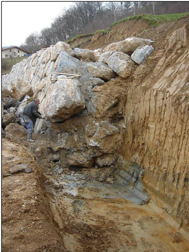
Ilustración 1-26 Inestabilidad de taludes en roca. [37]
