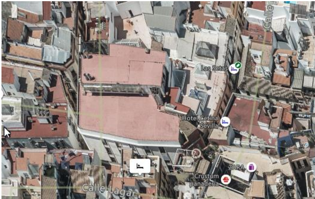
Figura. 11. Vista aérea del edificio.
