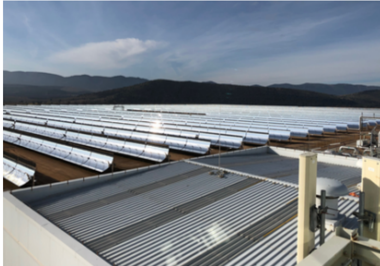
Figura 2.5 Imagen de una planta termosolar CSP con tecnología cilindro-parabólica.
