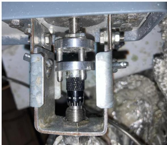
Figura 3-9: Servo-válvula
