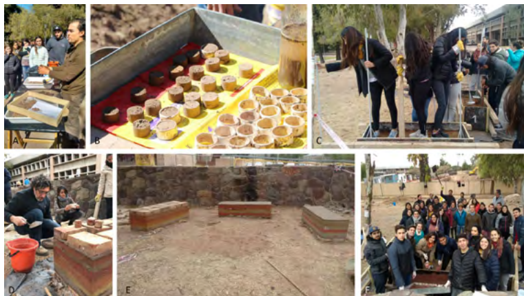
Figura 3. Fase formativa. Taller de identificación de suelos (A, B). Ejecución de la tapia mediante apisonado (C), Asesoramiento de técnicos especializados en los detalles de la terminación (D), Piezas de tapia terminadas (E) y participantes (F).
