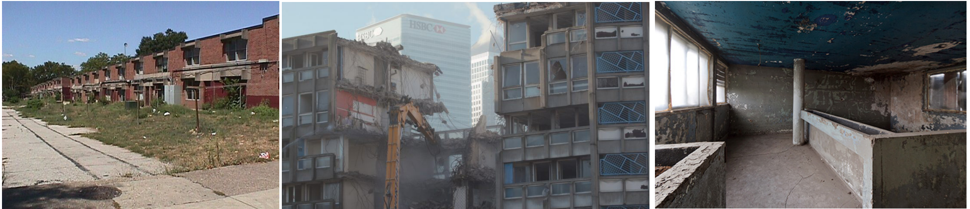
Fig. 3. Una calle de la Mill Creek Housing en Filadelfia poco antes de su demolición. Demolición del Robin Hood Gardens. Interiores del Narkomfin antes de su rehabilitación.
