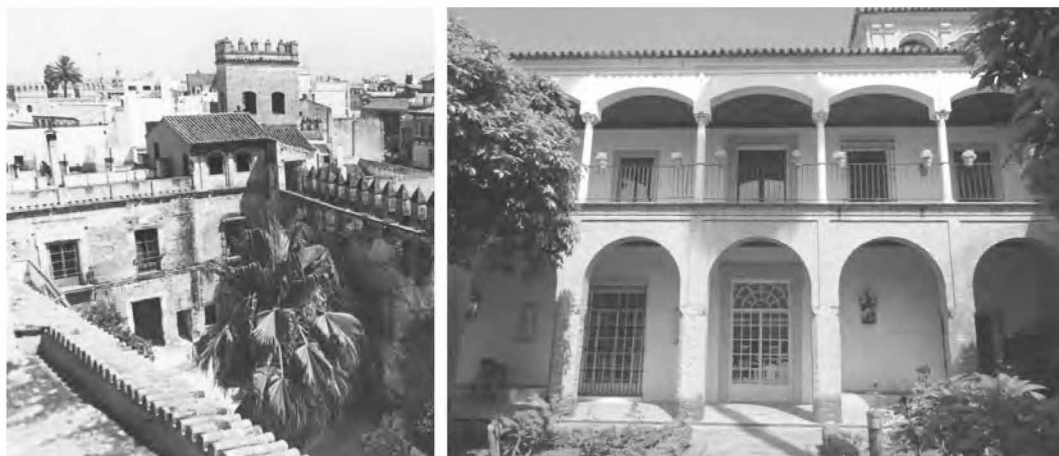
Figura 05. Frente delantero del Patio del Tenis. Antes y después de la intervención.
