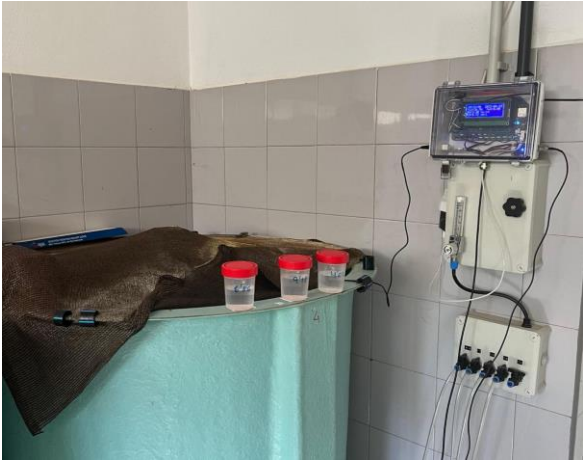
Figura 104 – Instalación con prototipo Aquacol en PCB (1)
