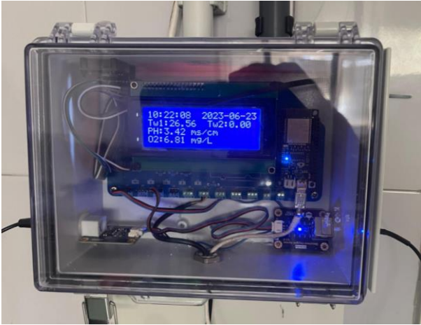
Figura 105 - Instalación con prototipo Aquacol en PCB (2)
