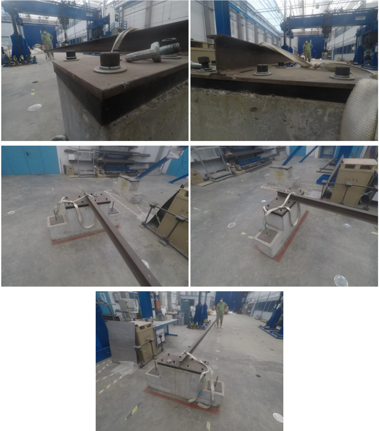
Figura 5-29. Reportaje fotográfico del apoyo de la viga.
