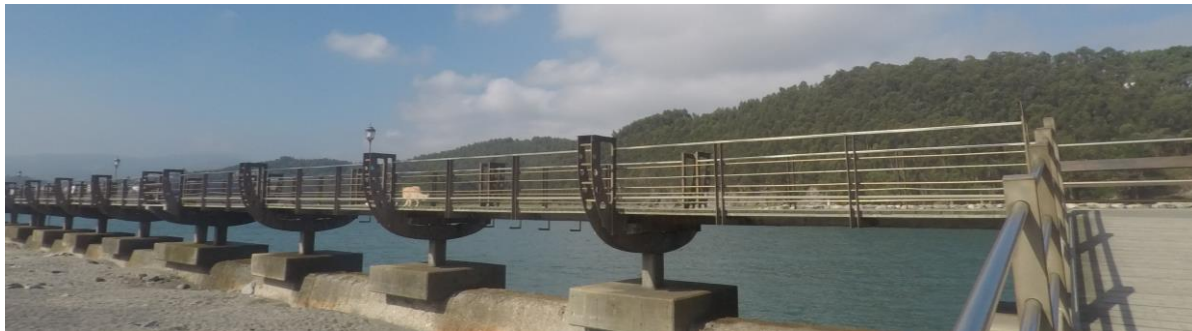
Figura 5-64. Pasarela sobre la que se efectuará el ensayo.
