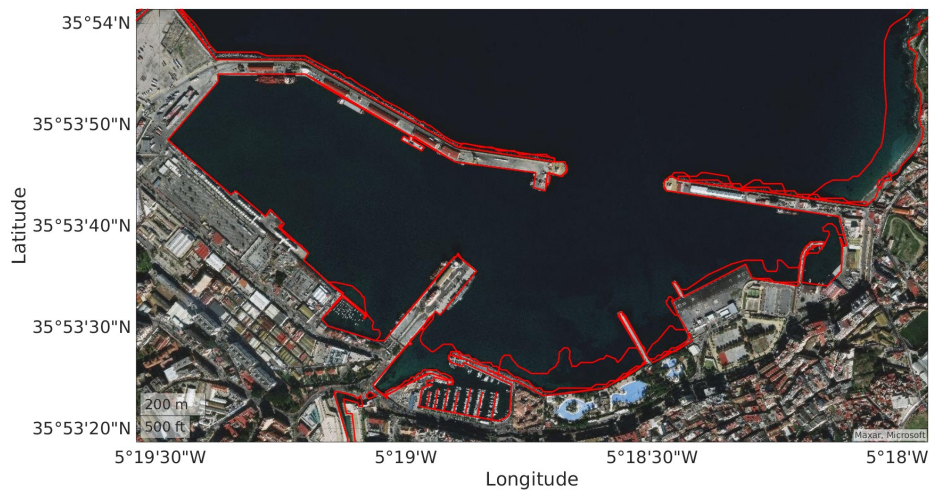
Figura 5.2 Visualización en detalle de los elementos considerados como obstáculos (rojo) sobre el Puerto de Ceuta.
