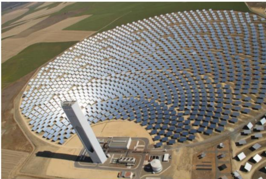
Ilustración 11: Planta PS-20, construida por Abengoa.
