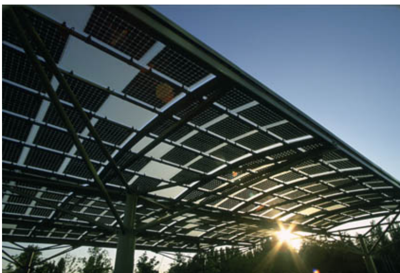
Figura 1.1 Instalación fotovoltaica sobre estructura [1].
