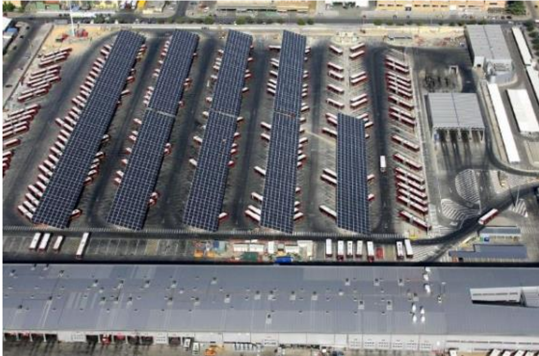
Figura 3.1 Instalación de placas solares en el aparcamiento de TUSSAM
