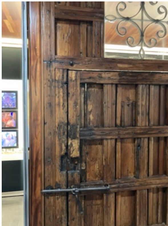
Figura 3.21. Portón de la casa de los Cepeda
