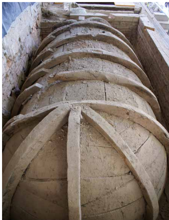
Il. 1. Bóveda 2. Fotografía previa a la intervención. Benjamín Domínguez. Fotografía previa a la intervención.
