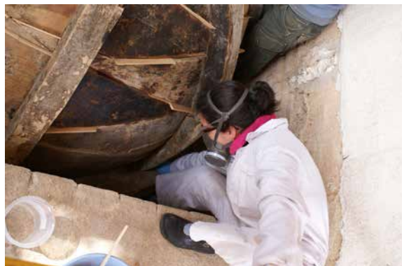
Il. 8. Bóveda 3. Tratamiento de conservación-restauración. La dificultad para acceder a algunas zonas dificultó notablemente la aplicación de algunos tratamientos. Benjamín Domínguez, 2007. GESTIONARTE S.L.U.
