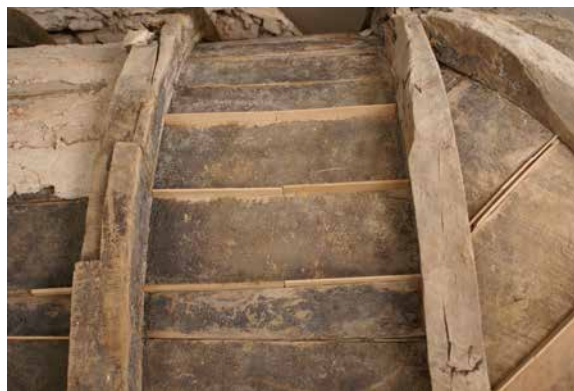
Il. 11. Bóveda 1. Tratamiento de conservación-restauración. Colmatado de las aberturas entre tableros mediante piezas de cedro. Benjamín Domínguez, 2007. GESTIONARTE S.L.U.
