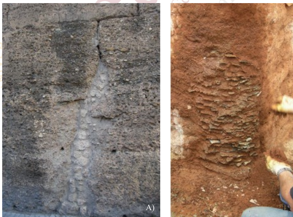
Figura 18. Restitución a una cara mediante bloques de machaqueo de tapia (A) y con lajas de piedra y mortero de tierra y cal (B)
