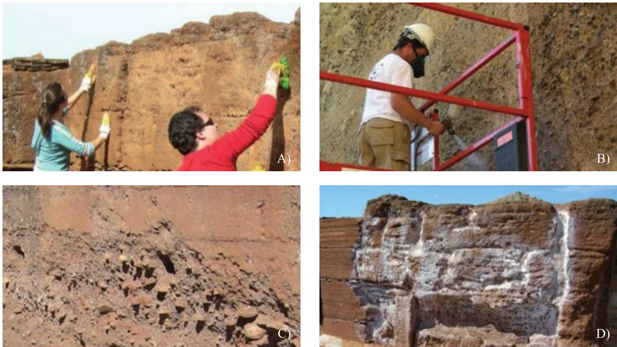
Figura 20. Limpieza superficial mediante cepillado (A). Tratamiento de consolidación con silicato de etilo (B). Erosión en la zona baja debido a la humedad ascendente y las sales solubles (C). Tratamiento de consolidación con agua de cal (D)
