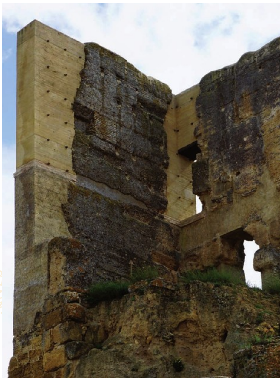
Figura 15. Restitución a dos caras en uno de los paños de la Torre del Homenaje del Alcázar del Rey Don Pedro de Carmona (Sevilla)
