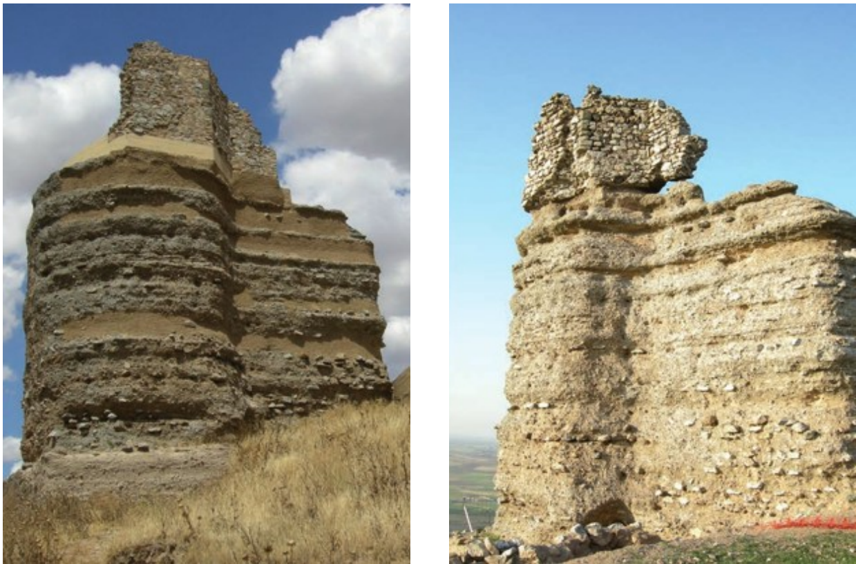
Figura 14. Restitución parcial a una cara de los volúmenes perdidos de una torre y un lienzo de la Alcazaba de Reina (Badajoz)
