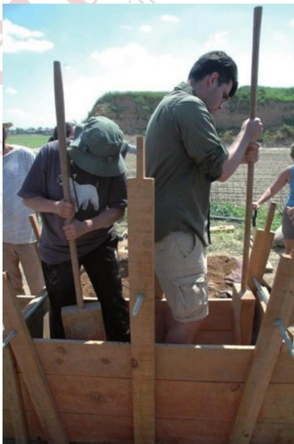
Figura 9. Proceso de apisonado de la mezcla en el interior del encofrado para la fabricación de un muro de tapia (Fot. O. Rodríguez)
