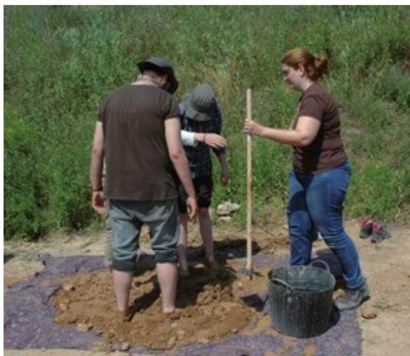
Figura 8. Proceso de pisado de la mezcla de tierra, agregados, aditivos y agua (Fot. O. Rodríguez)
