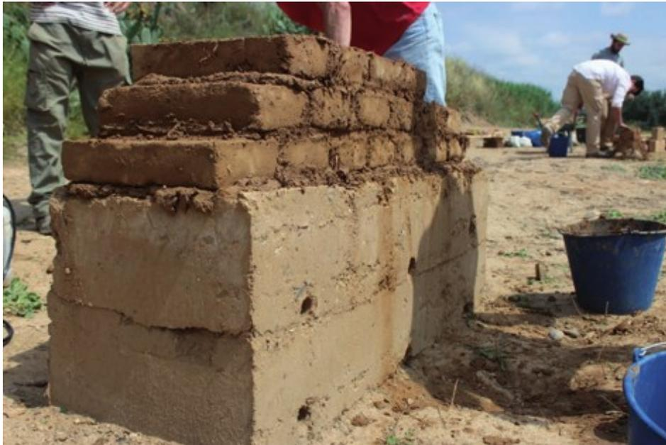
Figura 10. Recrecimiento con adobe de un muro con zócalo de tapia (Fot. F. B. Pérez de Castro)
