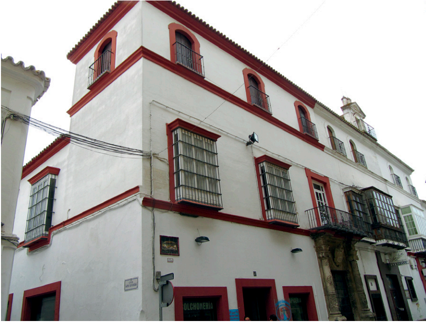
fig. 10 ¿Juan Rodríguez Portillo?, antigua casa de cargadores a Indias de los Gómez de Barreda, calle Santo Domingo nº 46-56, ca. 1730-1750. Sanlúcar de Barrameda. (Foto: Autor).
