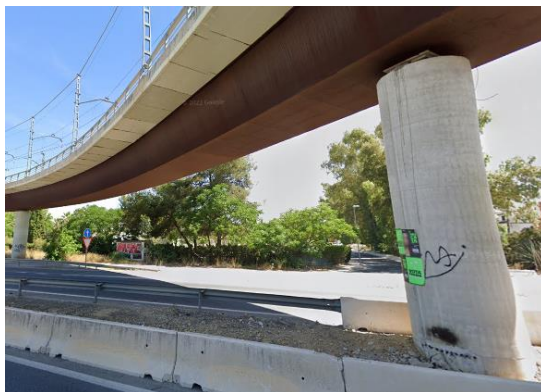
Figura 18. Puente de la línea 1 del metro de Sevilla sobre la A-376 [26]
