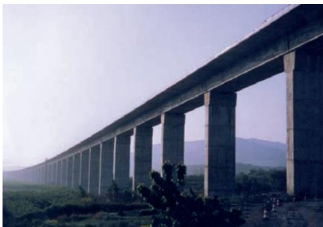
Figura 4. Vanos isostáticos del puente sobre el río Jalón y N-II [13]
