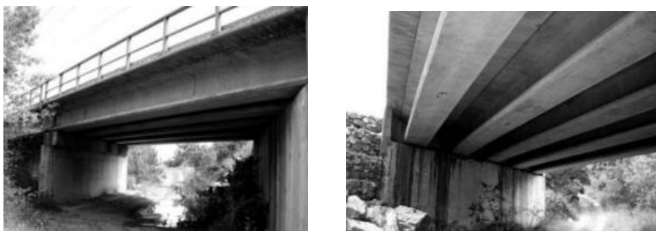
Figura 13. Vistas del puente Arroyo Bracea II [5]
