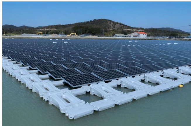
Figura 2-6. Sistema de flotación de la planta FPV de Kato (Japón). [20]
