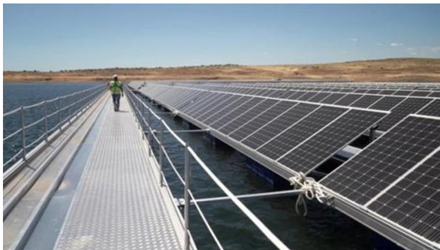
Figura 2-5. Planta fotovoltaica flotante del embalse de Sierra Brava, Cáceres. [17]
