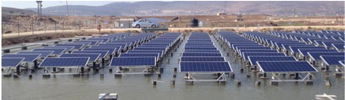
Figura 2-7. Sistema de flotación de Solaris Synergy. [21]
