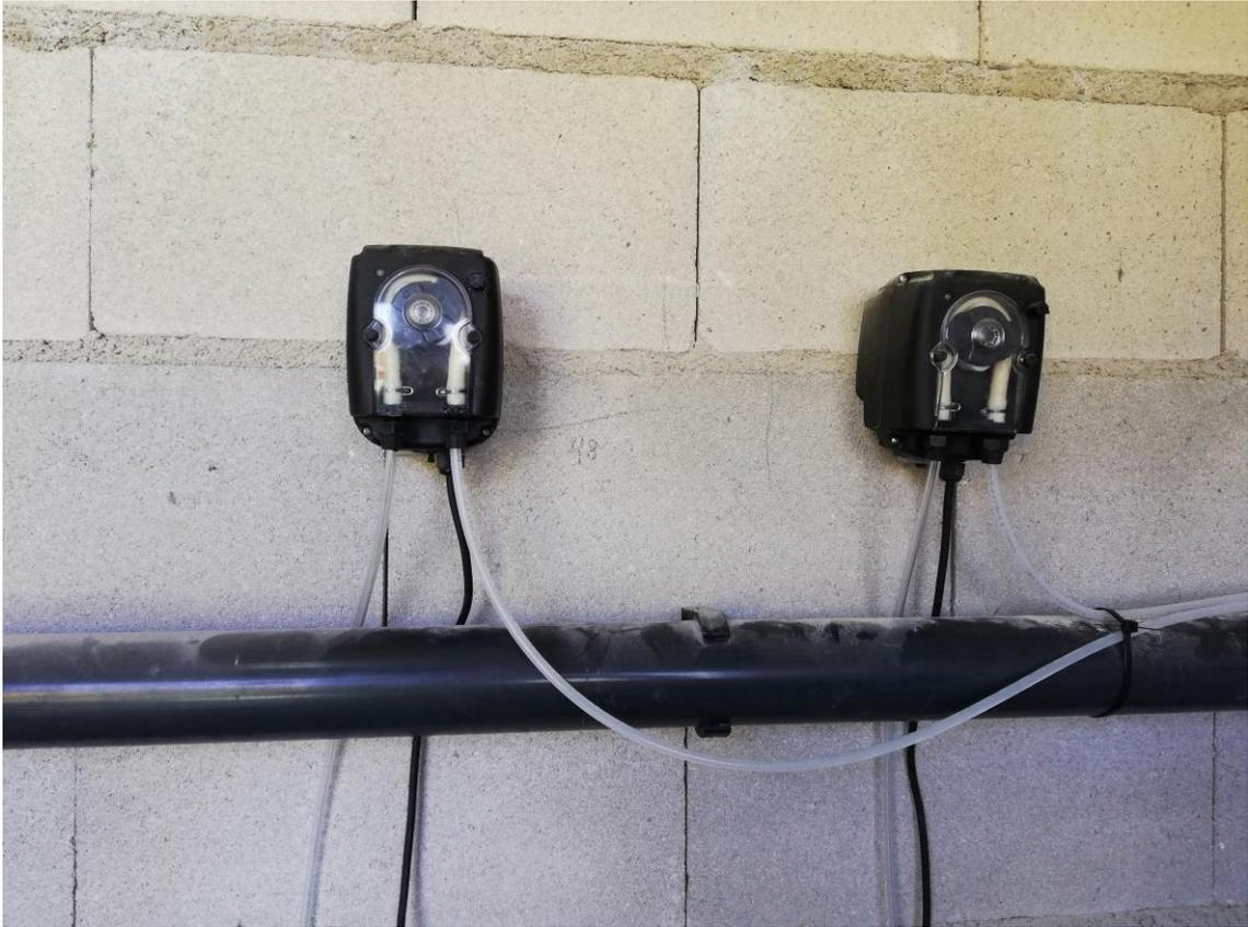
Figura 1-3. Bombas dosificadoras de ácido y lejía.
