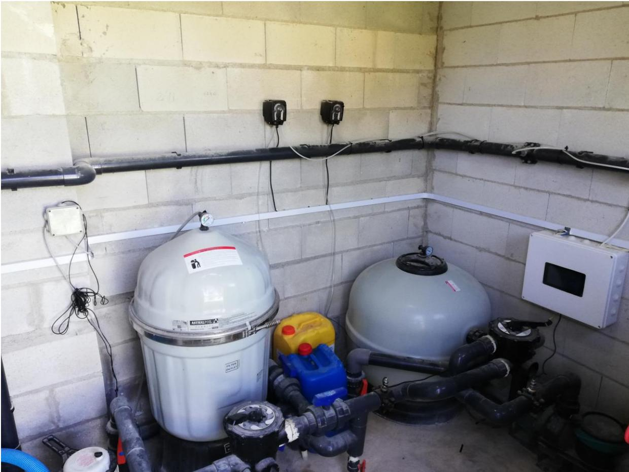
Figura 1-2. Sistema de depuración y control de la piscina.
