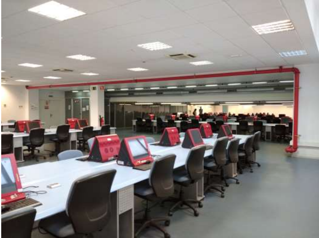
Imagen 13. Fotografía Sala Ordenadores Planta Sótano.
