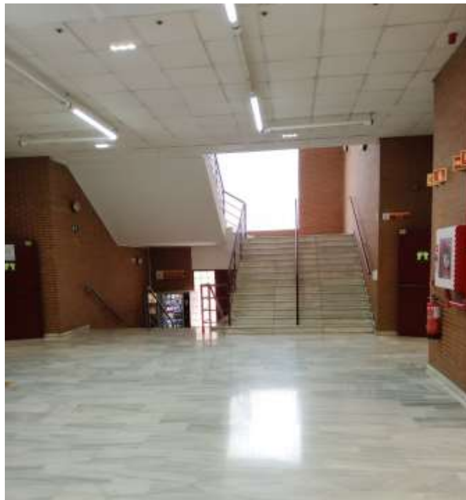
Imagen 15. Fotografía Escalera lateral derecha, planta baja.
