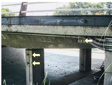
**Figura 5.17** Nodos sensores en un escenario de monitorización de un puente.
